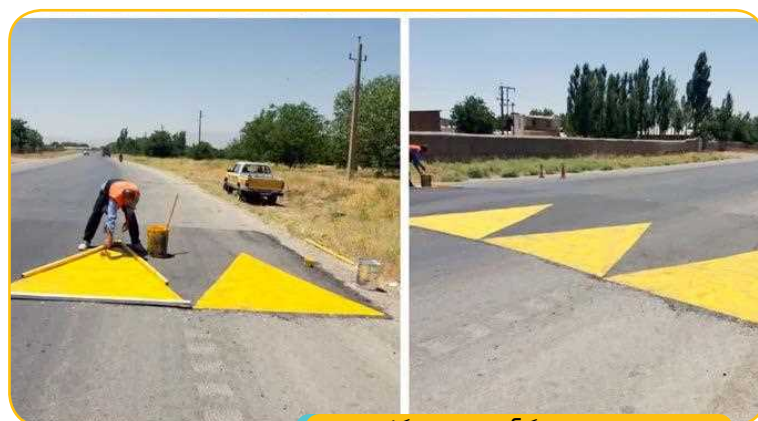
احداث سرعتگاه و رنگ‌آمیزی تقاطع گذرکچین
