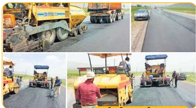
عملیات روکش آسفالت اسدآباد-آجین
