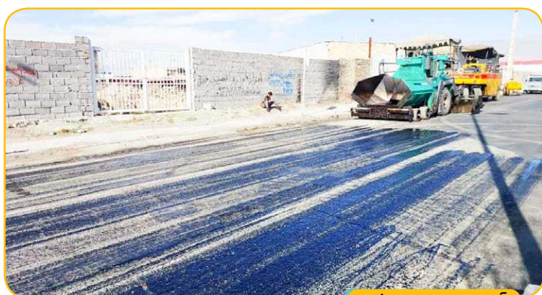
آسفالت ریزی سطح شهر
