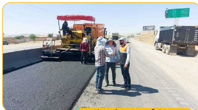
عملیات روکش آسفالت پالیز-کنگاور پل شکسته
