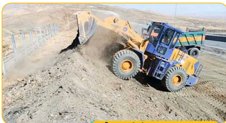
ایجاد خاکریز حفاظتی کولاک گیر گردنه اسدآباد
