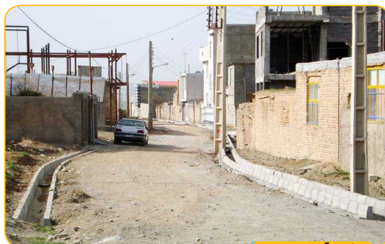
شمس آباد- حین اجرا
