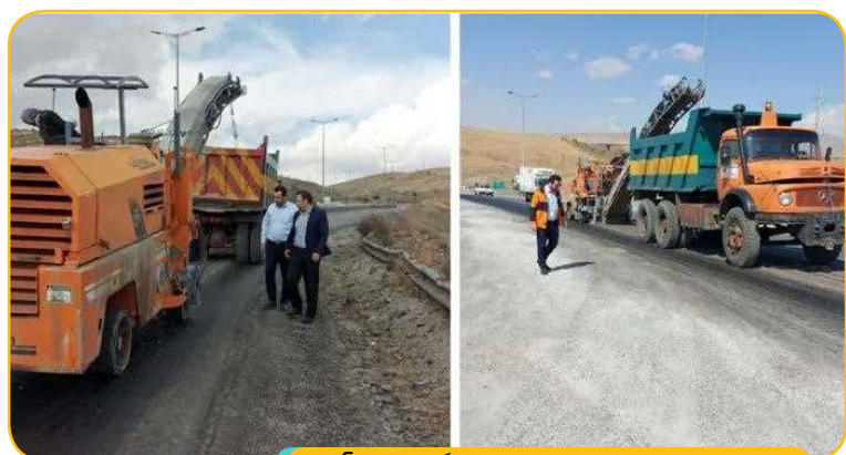
عملیات مفرس کردن رویه راه محور گردنه اسدآباد
